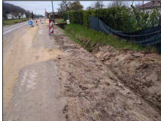
Figure 18 : Réfection de fossé
